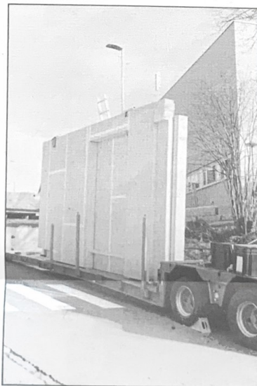
Die vorgefertigten Elemente stammen vom Mellinger Betrieb Conrad Holzbau und wurden per Lastwagen nach Stetten gebracht. Um die Holzelemente zusammenzusetzen, war Kran-Massarbeit gefragt.
