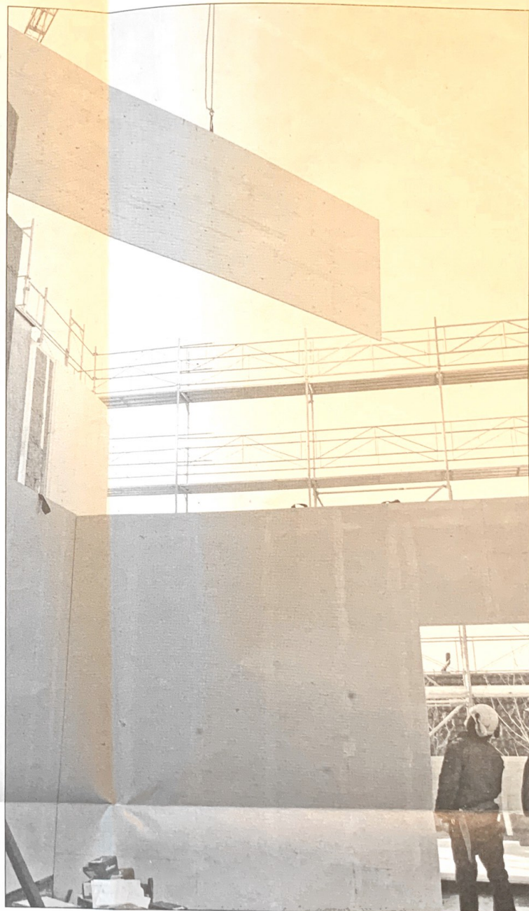
Die vorgefertigten Elemente stammen vom Mellinger Betrieb Conrad Holzbau und wurden per Lastwagen nach Stetten gebracht. Um die Holzelemente zusammenzusetzen, war Kran-Massarbeit gefragt.
