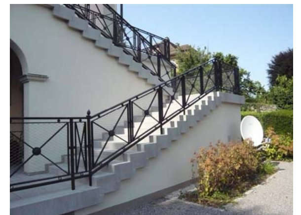
Treppenaufgang nach der Sanierung
