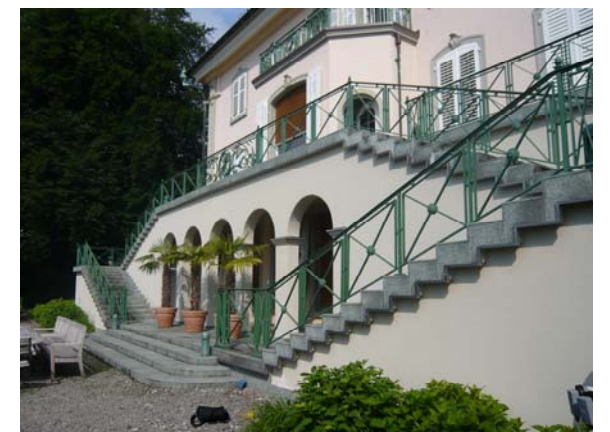
Treppenaufgang und Terrasse vor der Sanierung
