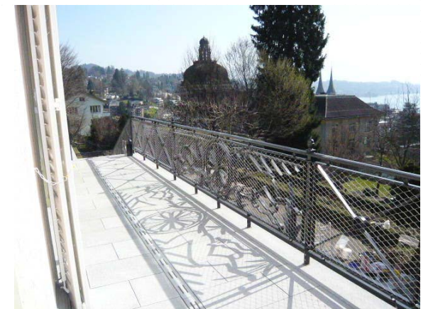
Detailansicht restauriertes Geländer
