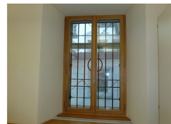
Neues Naturholzfenster im Erdgeschoss
