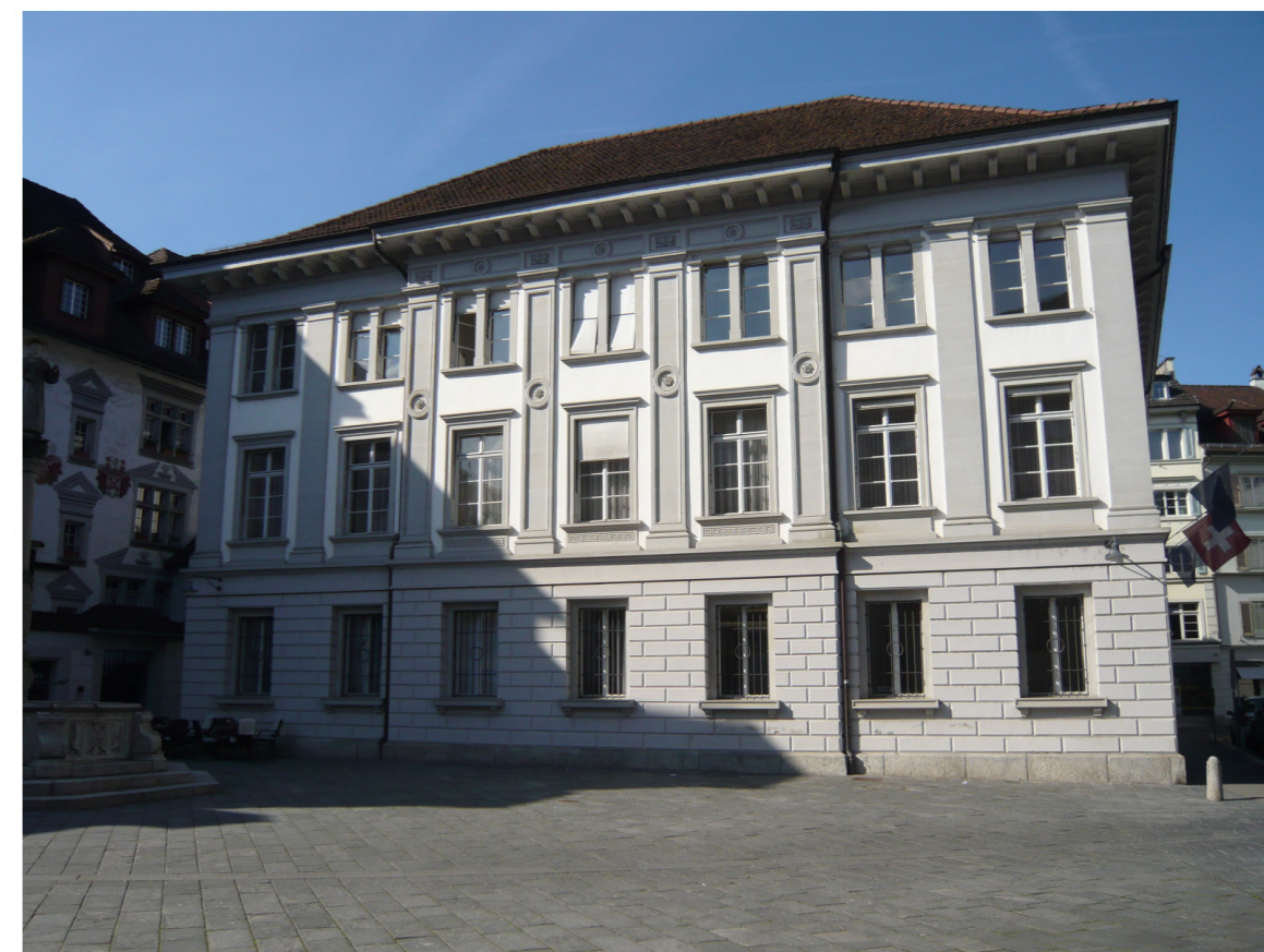
Südfassade vor der Sanierung mit bestehender Beschattung im 1. und 2. Obergeschoss
