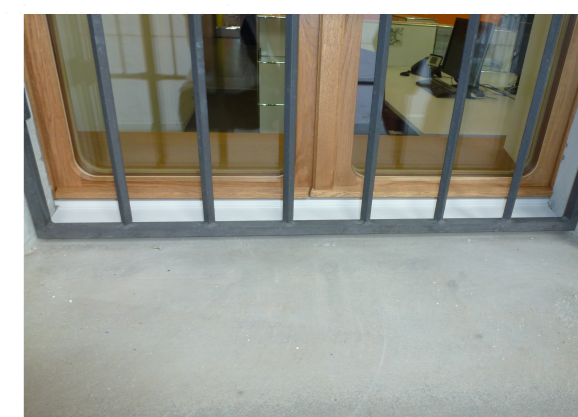
Neues Naturholzfenster im Erdgeschoss, Ansicht von Aussen
