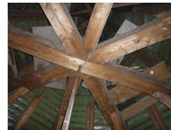
Detailansicht bestehende Dachkonstruktion
